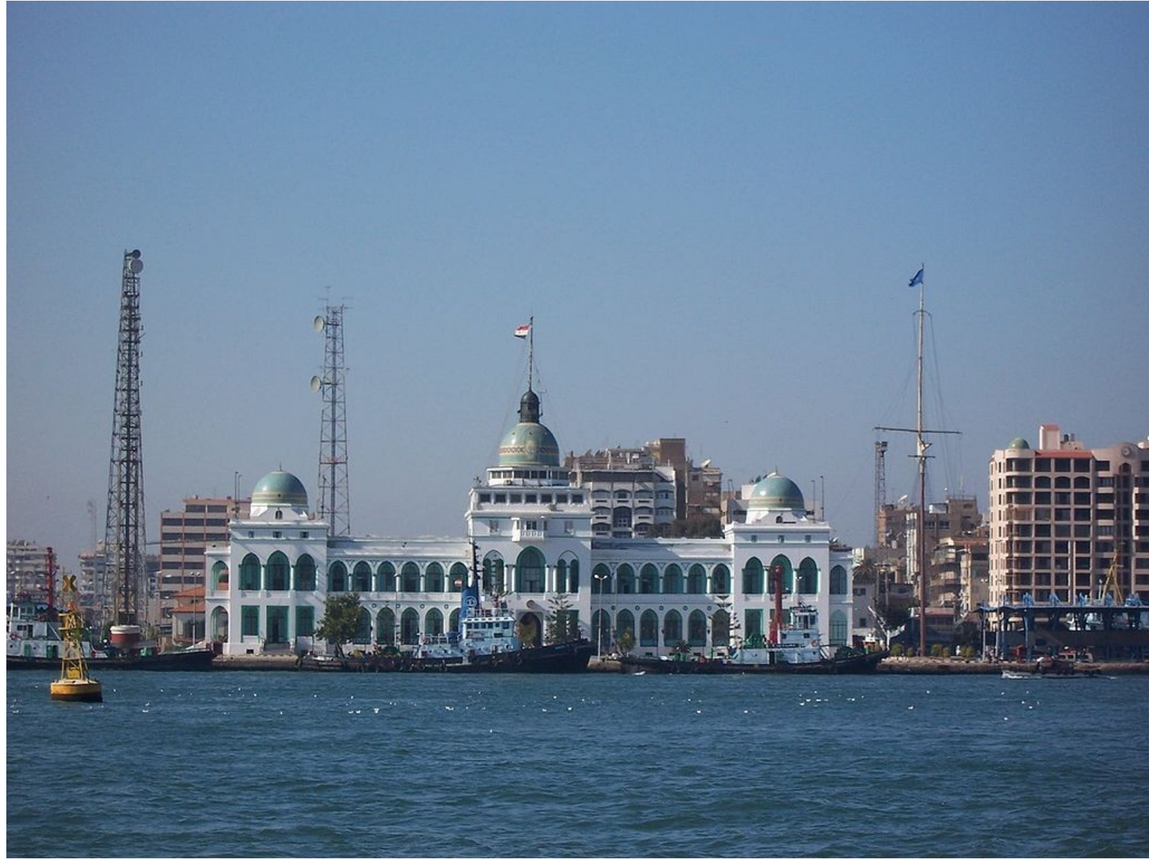
مبنى هيئة قناة السويس
